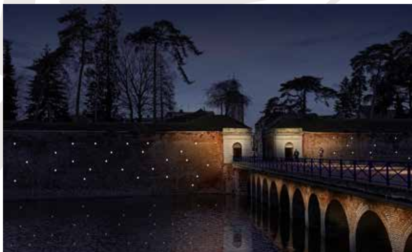
Le plan lumière a été préparé par le Cabinet S 2 lumière. Il repose non sur un éclairage massif, mais sur une mise en valeur toute en finesse des arches du Pont Fauroeux, ou encore des boutisses, qui solidifient historiquement la muraille.
